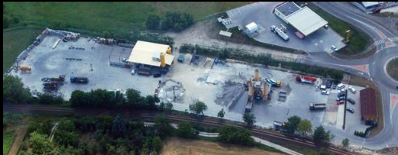
A Mobil-Mix Betonüzem Nyúli Telepe
